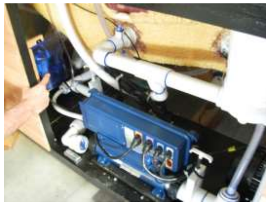
Funktionskontrolle: Hier brennt unten in der Mitte ein grünes LED und das Gerät summt leise. (nur in der Umwälzphase!)
