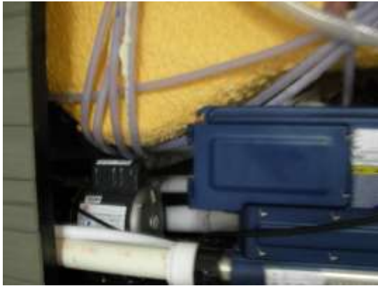
Umwälzpumpe ist links hinter Einheit
